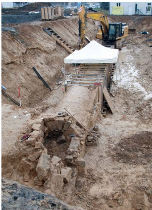
Bild 1: Die Eifelwasserleitung in Hürth-Hermülheim während der Bergungsarbeiten
