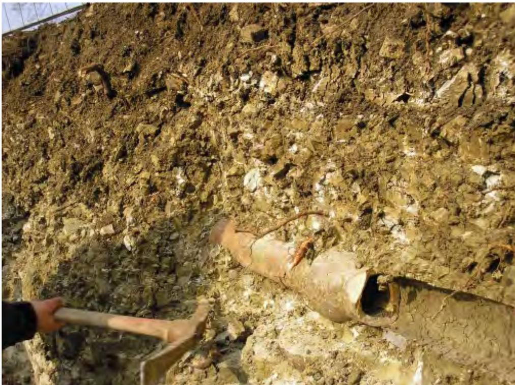
Die Bilder zeigen die Steinzeugrohre in der Grabenwand der Sanierungsbaustelle
