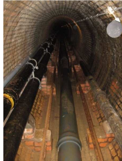
Blick in den Schläferskopfstollen
