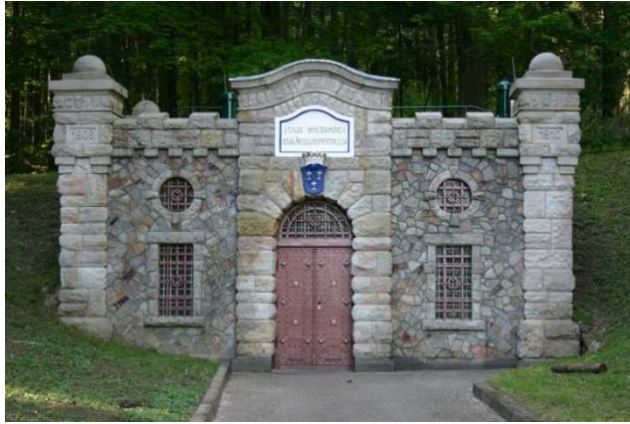
Portal des Schläferskopfstollens
