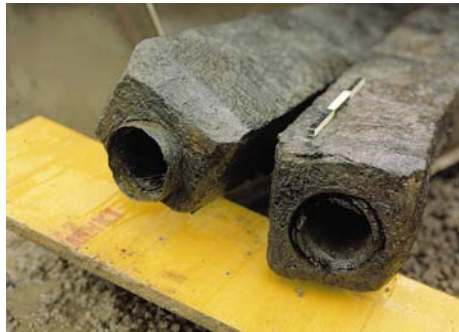
Holzrohre mit Deichelringen
