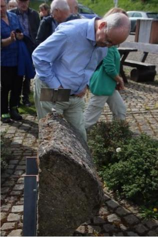
Ausgestellt ist hier auch ein beeindruckendes Beispiel der Kalksinterablagerungen in der Eifelwasserleitung. Die Römer haben bewusst ein Wasser gewählt, das stark kalkabscheidend ist. Dies hatte den Vorteil, dass in den Bleileitungen in Köln das Wasser durch die Sinter-Schutzschicht nicht direkt mit dem Blei in Berührung kam. Denn die Römer wussten schon damals, dass bleihaltiges Wasser für die Gesundheit abträglich ist.
